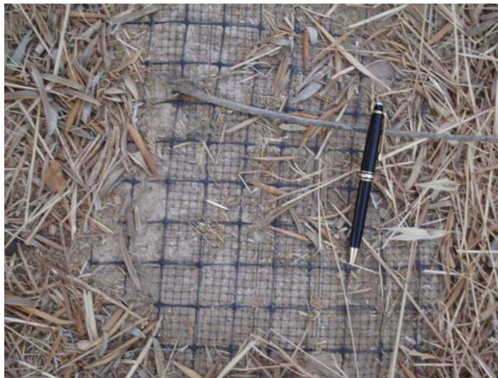
Foto 9.- Detalle de la adherencia al suelo de la manta orgánica tipo 2K3R.
