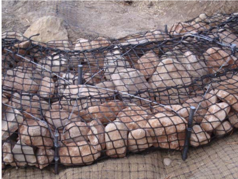
Foto 10.- Detalle de amarre de gaviones flexibles colocados como trampa de sedimentos.
