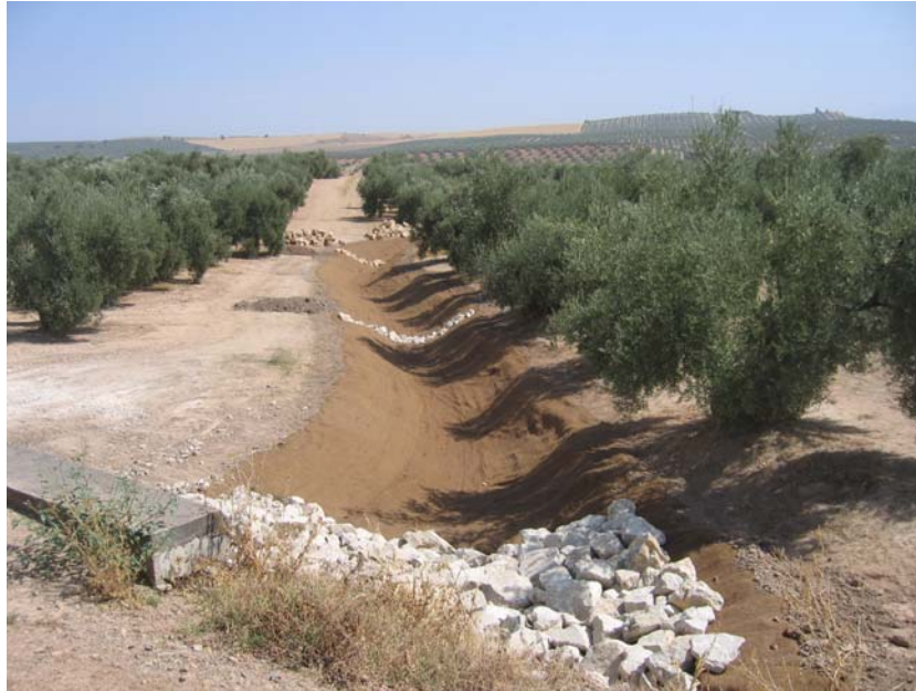
Foto 4.- Embocadura del tratamiento en agosto de 2007. Rip-rap en primer término
