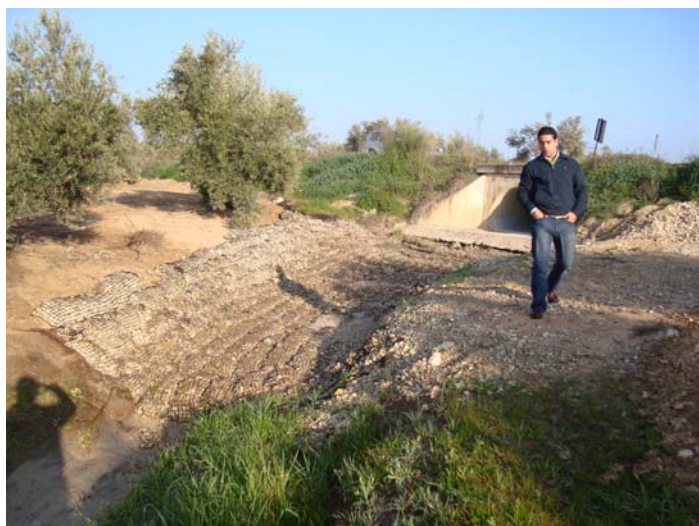
Foto 11.- Embocadura del tratamiento a base de gaviones flexibles
