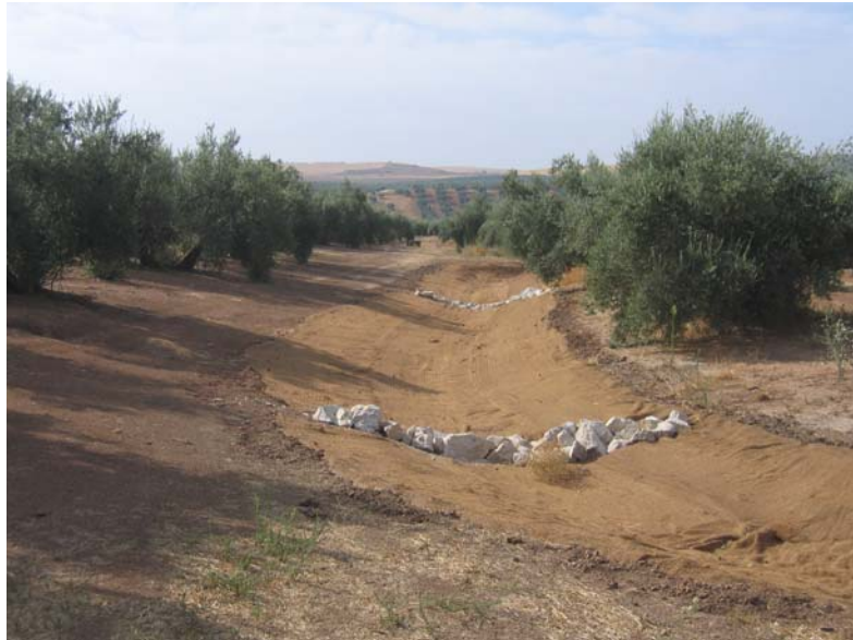
Foto 3.- Tratamiento convencional de mantas 2ER y zanjas de atado (agosto 2007)
