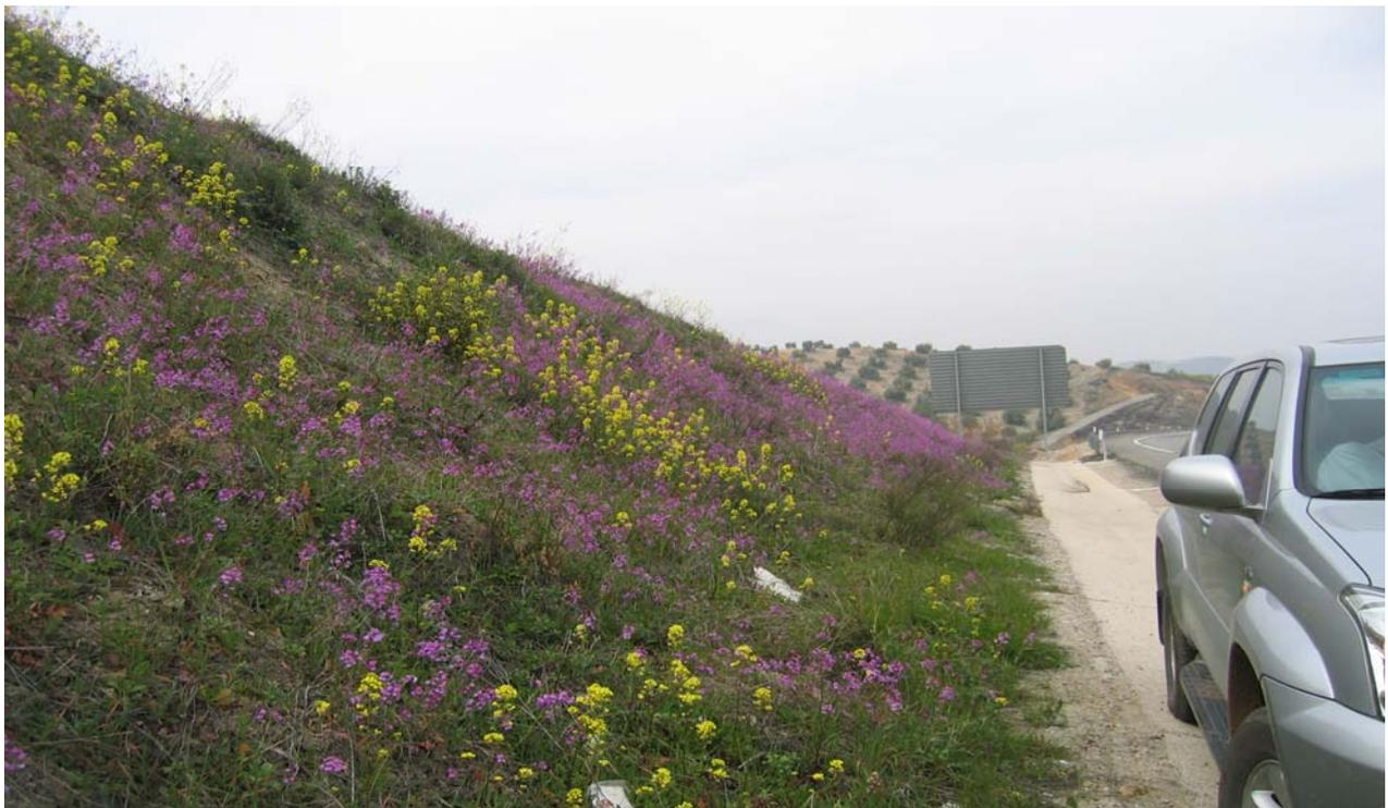
**Foto** A 44. Jaén: talud estabilizado definitivamente con diversidad de vegetación y sin erosión, ejecutado con hidrosiembra y manta orgánica.
