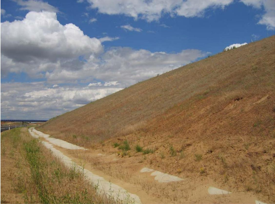
Foto Autovía Benavente- León: taludes hidrosembrados sin y con tratamiento de cobertura de manta orgánica
