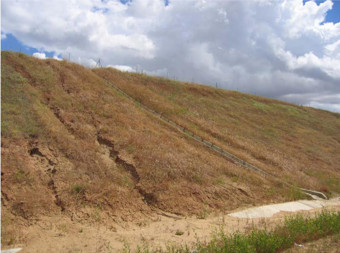
Foto.- Bajante de aguas de piezas prefabricadas que no cumple su función de recogida,
