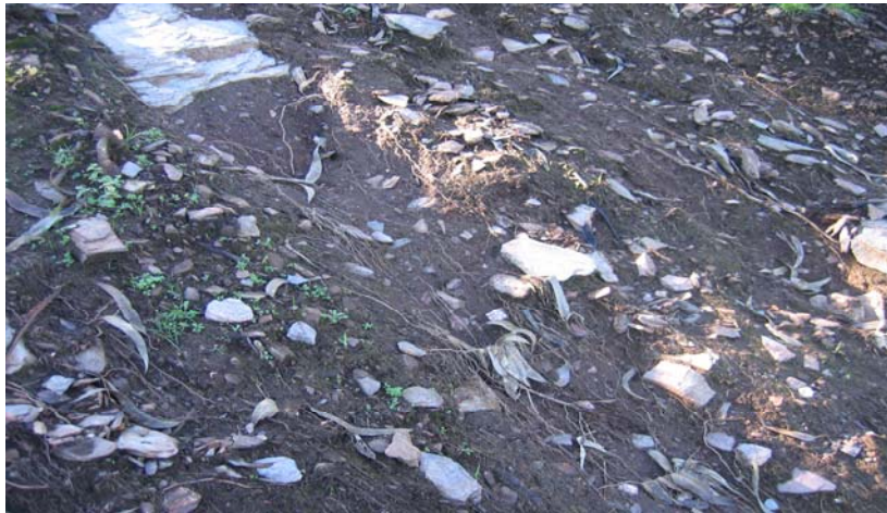
Foto 1 —Detalle del suelo afectado por erosión. Sierra d'Ossa.
