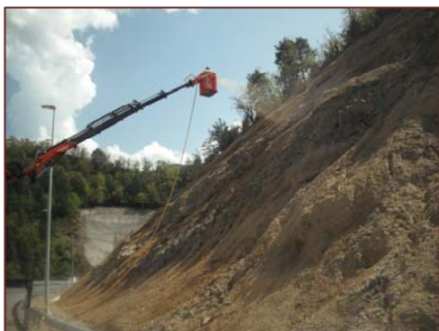
Proyección de hidro mulch
