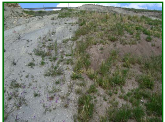
Detalle de las parcelas sobre la que se ha extendido tierra vegetal e hidrosiembra con y sin manta 3D (Abril 2.008)
