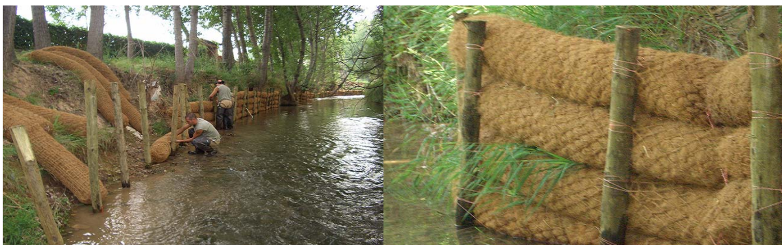
Foto 1- Instalación de biorrollos en las márgenes de un tramo del río Turia (Teruel).
