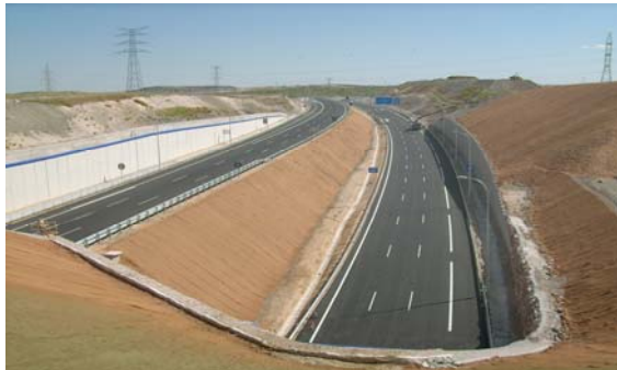
Foto 1- Obra en taludes de la M-50 de Madrid. Mayo 2007.
